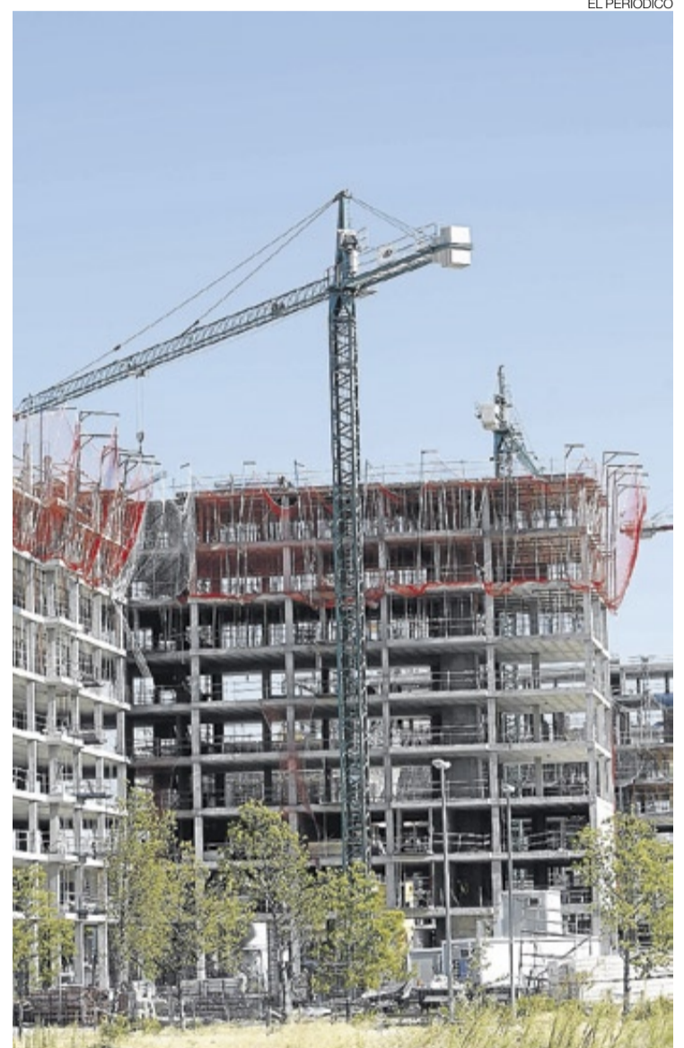
▶ Una de los bloques de vivienda que se están levantando en Zaragoza.
